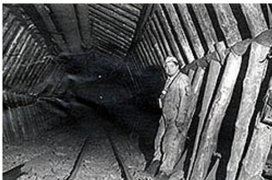
Richtstrecke mit Polygonausbau als Verstärkung gegen starken Gebirgsdruck (1965)
