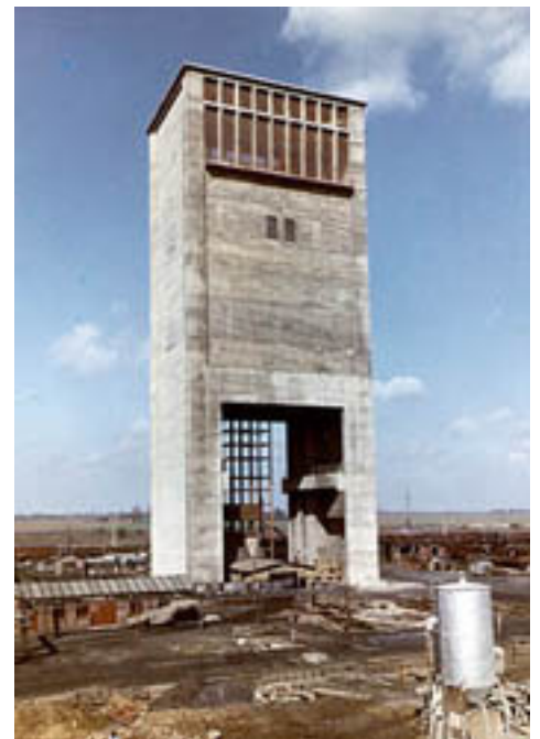
Neuer Förderturm im Rohbau, Schacht II (Mitte der 50er Jahre)
