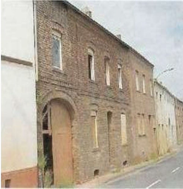
Inden vor dem Abbruch
